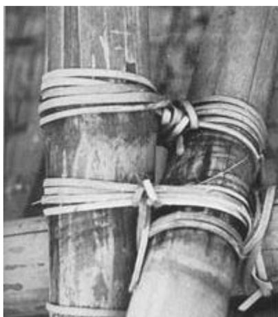
**Seilbund:** Die gebräuchteste Art der Verbindungen von Bambuskonstruktionen an einem 'Knotenpunkt' ist der Seilbund. Die Bindemittel sind ebenfalls aus organischem Material und sorgen dadurch für eine optimale Verträglichkeit zwischen den einzelnen Elementen innerhalb des ganzen Konstruktionssystems.
