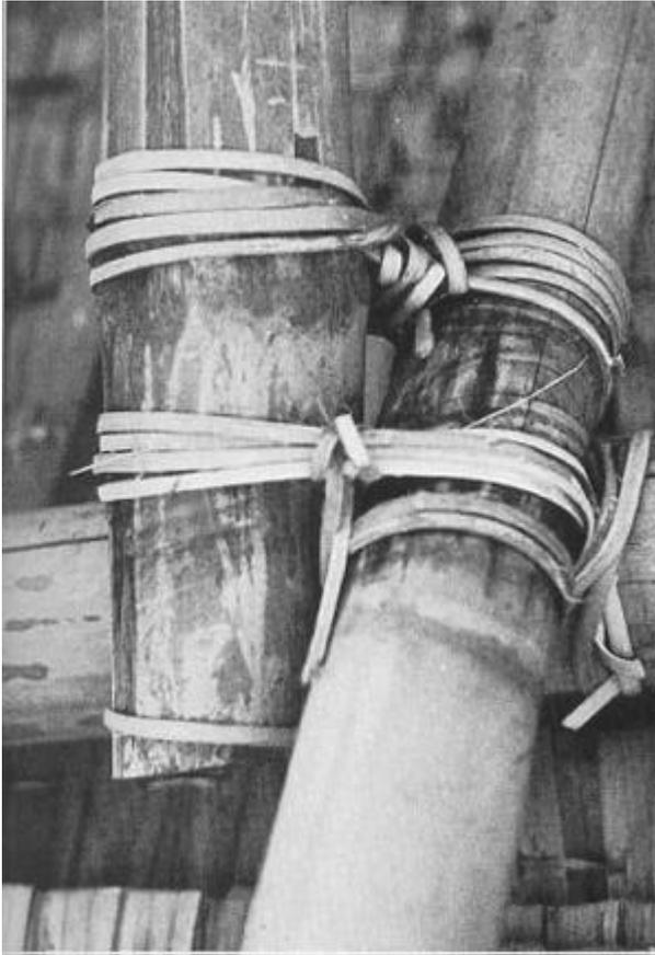
Verbindung mit Bambusstreifen.
